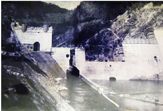
建設中の津賀ダム
